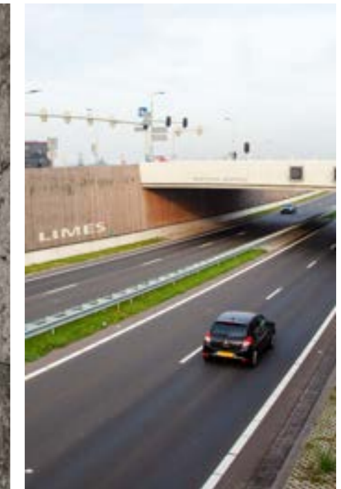
Herkenbare architectuur in tunnelbak bij de Tjalmaweg in Katwijk. (Afb: ZJA Architects & Engineers)
